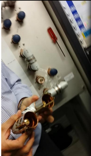
รูปที่ ๑๙ : สายรวมสัญญาณ ๒ Coax
