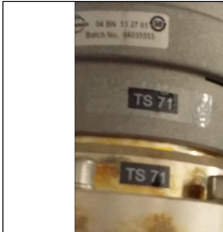
รูปที่ ๕ : ท่อส่งสัญญาณ Combined ไปยัง Antenna TS 71
