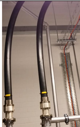
รูปที่ ๘ : ท่อส่งสัญญาณจาก Multiplexer CH33 และ CH35
