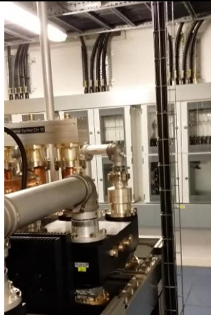
รูปที่ ๙ : ท่อส่งสัญญาณจาก ๒ Multiplexer ไปยัง Combiner ไปยัง Antenna TS 71
